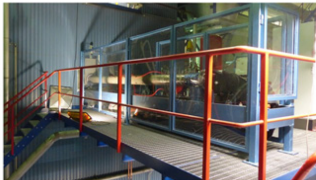
Installationen av Ecotube i Västervik
