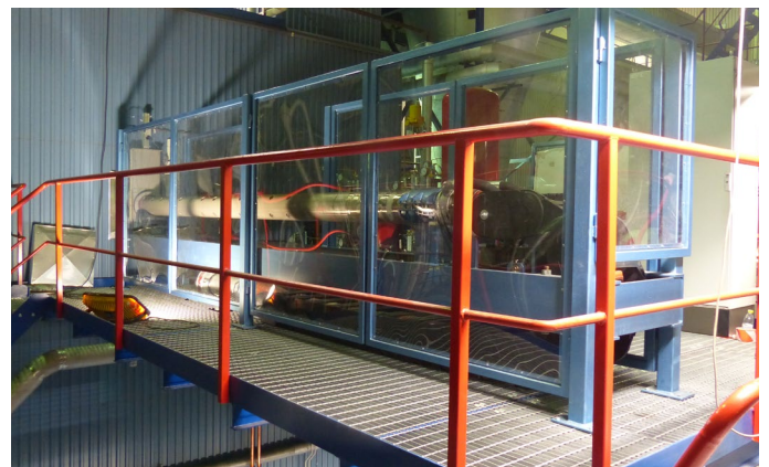
Installationen av Ecotube i Västervik
