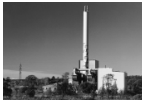
Värmeverket i Kristinehed, Halmstad
