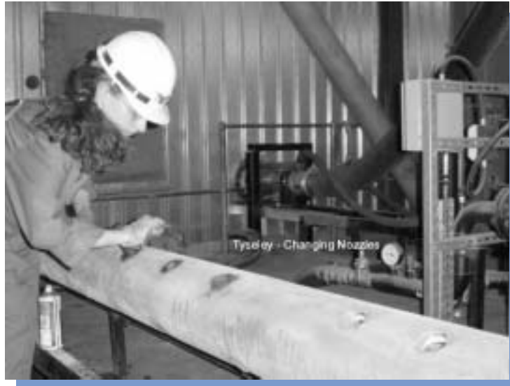
Sabine Samblat, Creed, i full färd med att gånga i luftmunstycken i en av Ecotuberna
