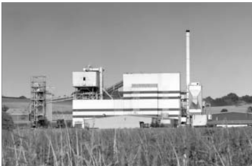
Anläggningen i Glanford ligger vackert belägen i en jordbruksbygd nära Grimsby på den engelska nordostkusten.
