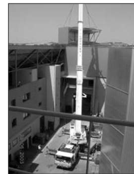
Plattform med väggar för Ecotuberna lyfts på plats i Bessieres
