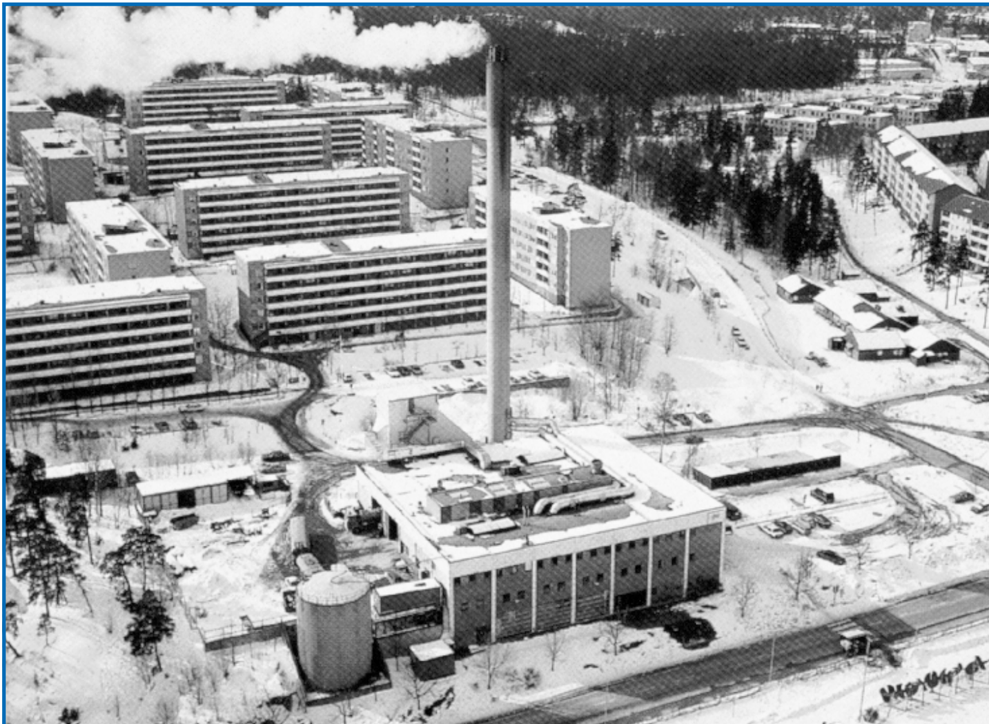
Vy över Bollmora värmeverk, centralt beläget i Bollmora sydost om Stockholm.
