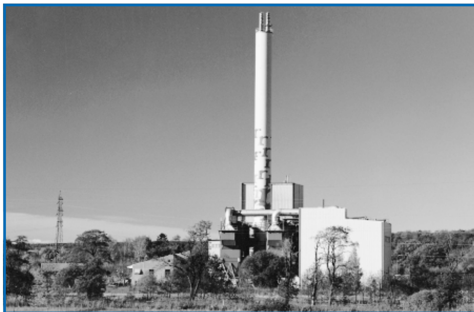
Vy över Värmeverket i Kristinehed, Halmstad
