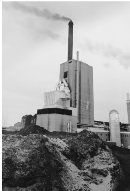
Vy över Karskärsverket, beläget inom Korsnäs område, 10 km s.o. Gävle. Ur barkhögarna i förgrunden produceras el, processånga och fjärrvärme.
